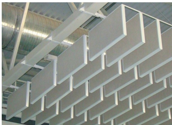
Рисунок 4.15 — Вид штучного (функционального) звукопоглотителя
