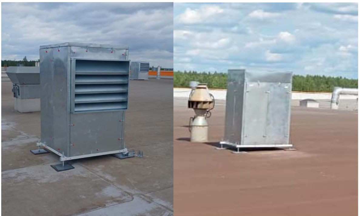
Рисунок 4.2.1 – Внешний вид конструкции шумозащитного кожуха для снижения шума крышной вентиляционной системы
