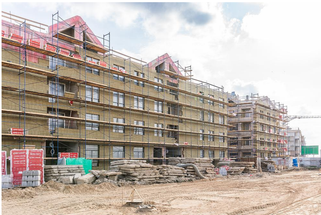
Рисунок 4.4 – Исследуемый участок строительной площадки ЖК «Пулковский дом» [122]
