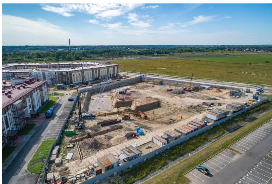
Рисунок 4.2 – Строительная площадка ЖК «Пулковский дом» [122]
