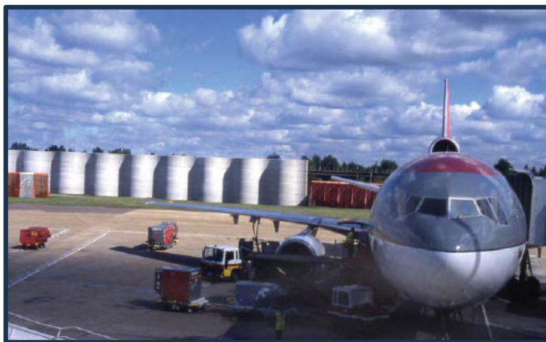
Рисунок 1.11 – 11-метровый железобетонный шумозащитный экран в форме волны, установленный в аэропорту
