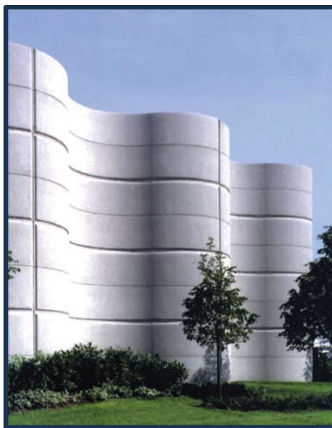
Рисунок 1.10 – 11-метровый железобетонный шумозащитный экран в форме волны, установленный в аэропорту
